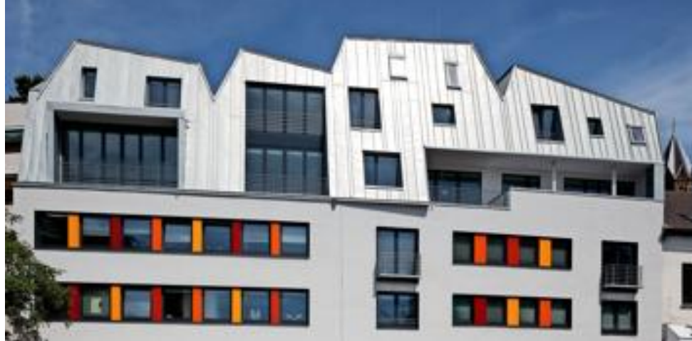
DRAUFGESETZT: Im nordrhein-westfälischen Bensberg wurde ein Wohn- und Geschäftsgebäude aufgestockt. Die oberen Geschosse setzen sich in Form, Farbe und Material stark vom Bestand ab und erzeugen so einen spannenden visuellen Kontrast.
